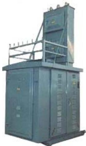
КТП-160 представляет собой трансформаторную подстанцию, предназначенную для обеспечения трехфазным питанием небольших промышленных и жилых объектов. Маркировка КТП расшифровывается как «комплексная трансформаторная подстанция», а 160 – ее полная электрическая мощность в киловольт-амперах.
